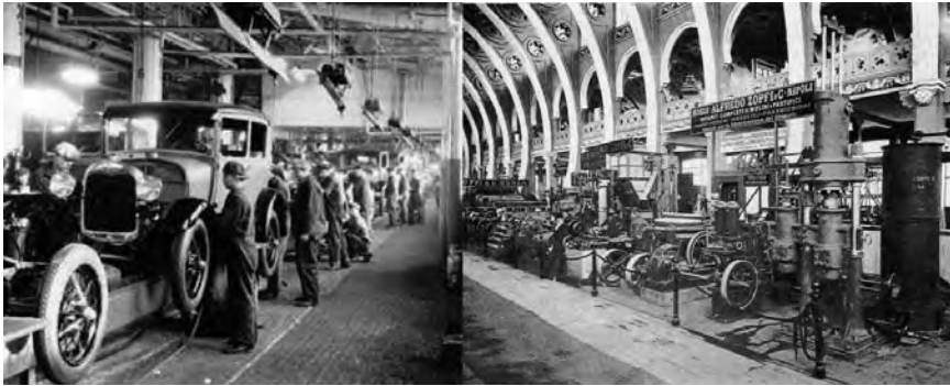
รูปที่ 1.4 ระบบสายพานเข้ามาใช้ในสายการผลิตรถยนต์
