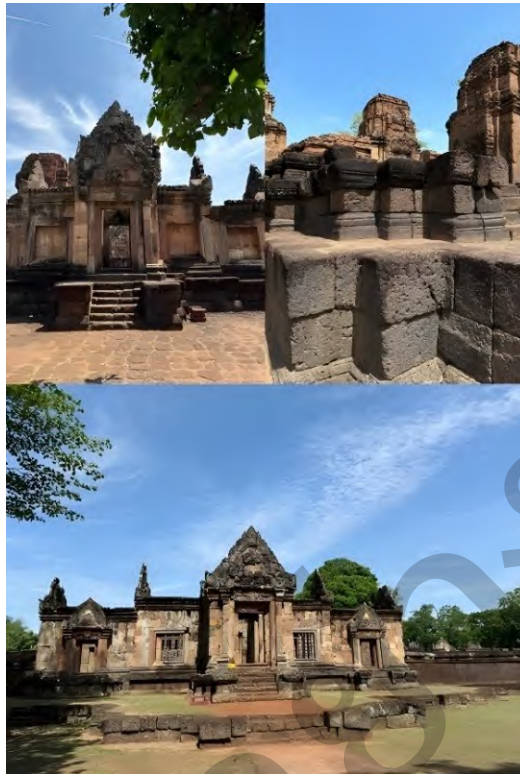
ภาพที่ 1.3 ลักษณะหินศิลาแลงและหินทรายที่ใช้เป็นวัสดุหลักในการก่อสร้างปราสาทเมืองต่ำ จังหวัดบุรีรัมย์ แสดงให้เห็นการเลือกใช้วัสดุท้องถิ่นที่มีความคงทนและสามารถรองรับโครงสร้างทางสถาปัตยกรรมโบราณได้อย่างมีประสิทธิภาพ
