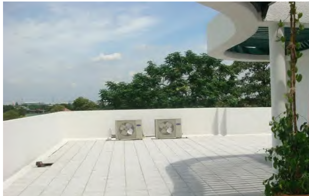
ภาพที่ 1.14 การติดตั้งแผ่นกระเบื้องคอนกรีตปูพื้นดาดฟ้าป้องกันความร้อนแบบโซลาร์บนพื้นดาดฟ้า
