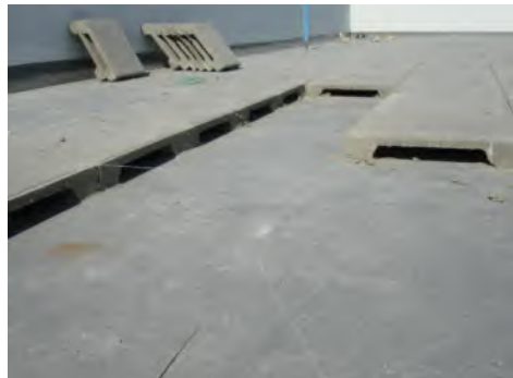
ภาพที่ 1.13 การติดตั้งแผ่นกระเบื้องปูพื้นดาดฟ้าป้องกันความร้อนแบบโซลาร์บนดาดฟ้า
