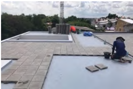
ภาพที่ 1.13 การติดตั้งแผ่นกระเบื้องปูพื้นดาดฟ้าป้องกันความร้อนแบบโซลาร์บนดาดฟ้า
