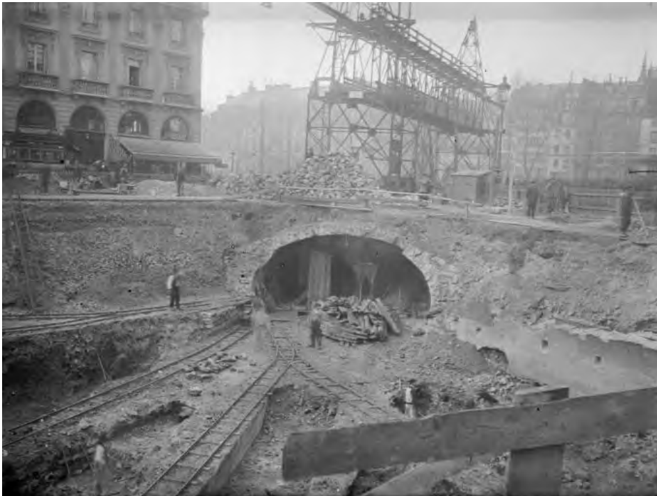
รูปที่ 1.11 การก่อสร้างรถไฟขนส่งมวลชนกรุงปารีสในช่วงปี ค.ศ. 1902 – 1910
