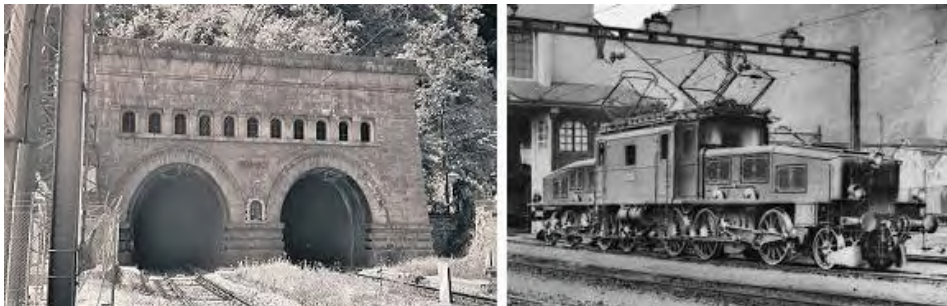
รูปที่ 1.4 Simplon Tunnel และรถจักรไฟฟ้า 3 เฟส
