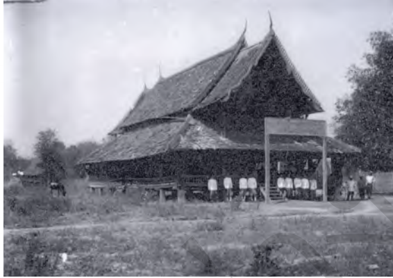
รูปที่ 1.1 ศาลเมืองนครลำปางในรูปแบบประเพณี (อาคารหลังนี้น่าจะสร้างในสมัยรัชกาลที่ 5 สังกัดจากข้อฟ้า ไบระกา ทางหงส์ที่รับอิทธิพลของสยาม) 8
