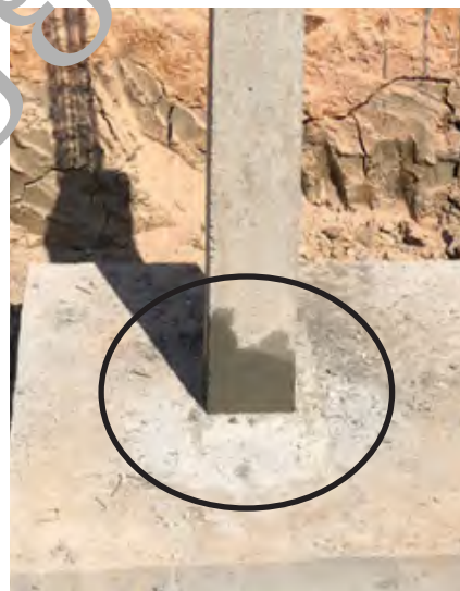
ข) การฉาบซ่อมแซมชี้นงาน
