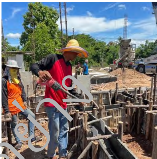
ข) การใช้เครื่องจี้คอนกรีต
