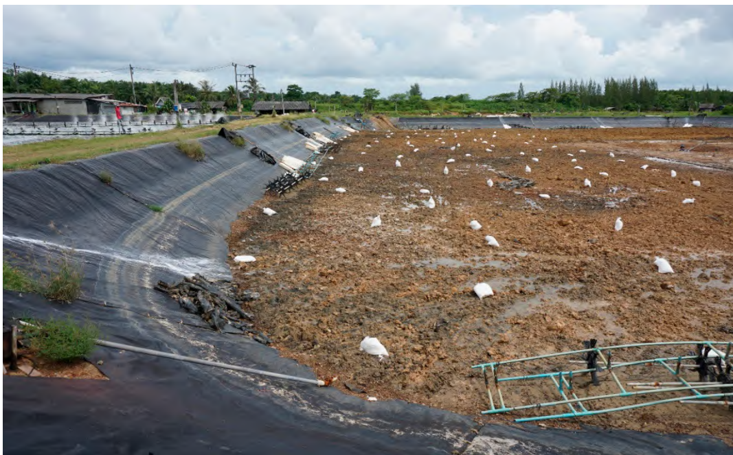
ภาพที่ 1.2 ดินพื้นบ่อยังพบสารอินทรีย์ตกค้างจากการเลี้ยงรอบที่ผ่านมา (สีดำ) กระจายอยู่ที่บริเวณต่าง ๆ ภายในบ่อ (ภาพหลังฉีดเลน) สารอินทรีย์ตกค้างสะสมในบ่อ ก่อให้เกิดปัญหาคุณภาพดิน น้ำ การเจริญเติบโต และการเกิดโรคในกุ้งได้ เมื่อบ่อมีอายุมากขึ้น
