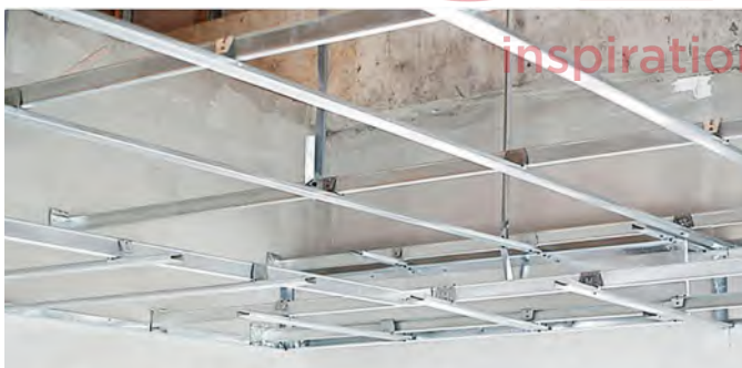
รูปที่ 1.16 โครงสร้างฝ้าเพดานซี-ลายน์
