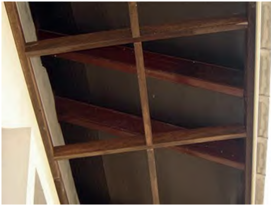
รูปที่ 1.15 โครงสร้างฝ้าเพดานไม้เนื้อแข็ง
