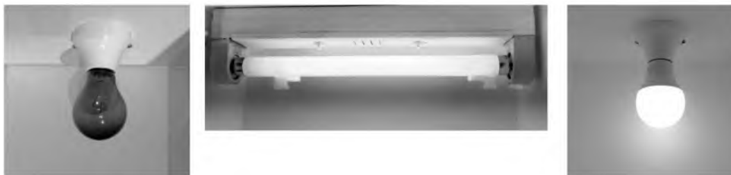
รูปที่ 2-7 (ก) หลอดทั้งสแตน (ข) หลอดฟลูออเรสเซนต์ (ค) หลอด LED halogen
