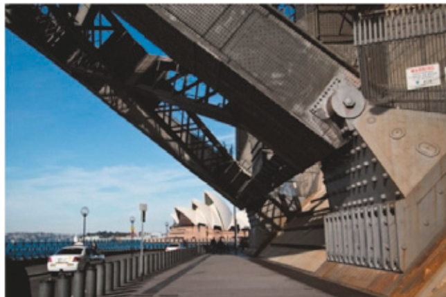
รูปที่ 1.13 แสดงจุดรองรับแบบหมุด
