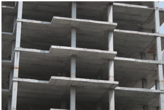
รูปที่ 1.5 โครงข้อแข็ง (Frames)
