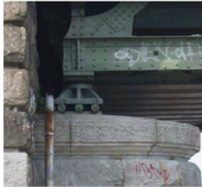
รูปที่ 1.15 แสดงจุดรองรับแบบล้อเลื่อน
