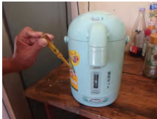
รูปที่ 1.3 การตรวจสอบกระแสไฟฟ้ารั่วไหล โดยใช้ไขควงทดสอบไฟฟ้าตรวจสอบ
