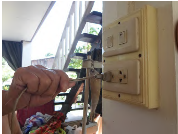
รูปที่ 1.5 การถอดเต้าเสียบที่ไม่ถูกต้อง โดยดึงที่สายไฟ
