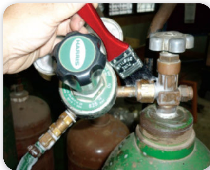
รูปที่ 1.13 แสดงการตรวจสอบด้วยน้ำสบู่เพื่อหารอยรั่ว
