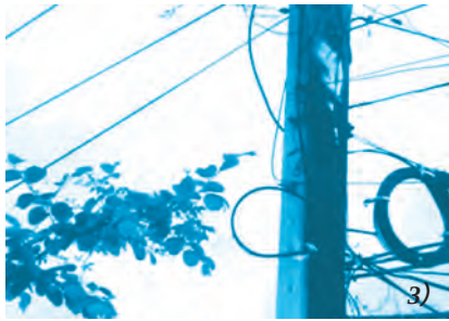
ภาพที่ 1.9 แสดงสาเหตุของการเกิดไฟฟ้าลัดวงจรจากฉนวนชำรุดและการติดตั้งไม่ได้มาตรฐาน
