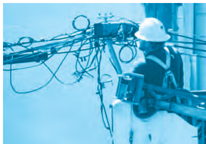
งานตรวจสอบสายนำสัญญาณ
