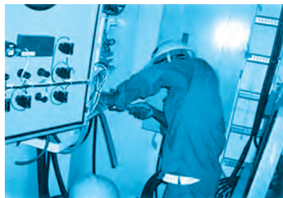
งานซ่อมแซมระบบตู้ควบคุมไฟฟ้า
