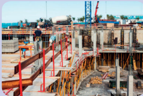
รูปที่ 1.3 การก่อสร้างอาคาร
