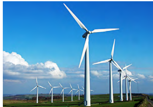
รูปที่ 1.20 พลังงานลม
