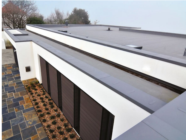
ภาพที่ 1.1 แสดงหลังคาแบนที่ติดตั้งระบบกันซึม
