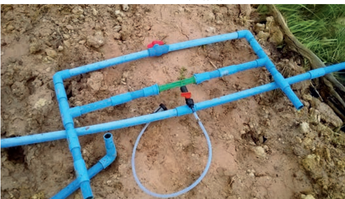
การวางระบบน้ำ
