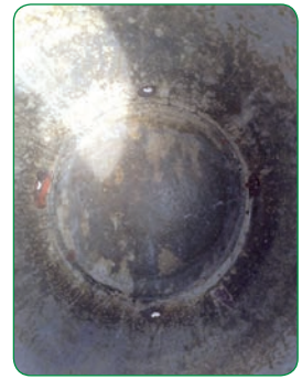
เจาะรูใต้โอ่ง 4 จุด โดยใช้ค้อนร้งเจาะ
