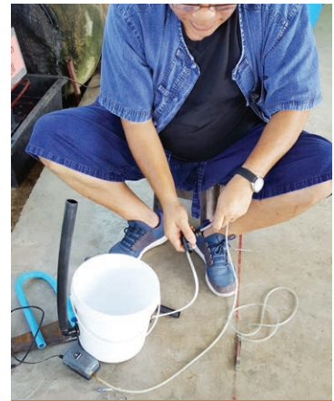
3. ใส่สายออกซิเจนปลาเข้าไปในลูกยางให้เข้าไปอยู่ในถัง แล้วใส่ช่องออก
